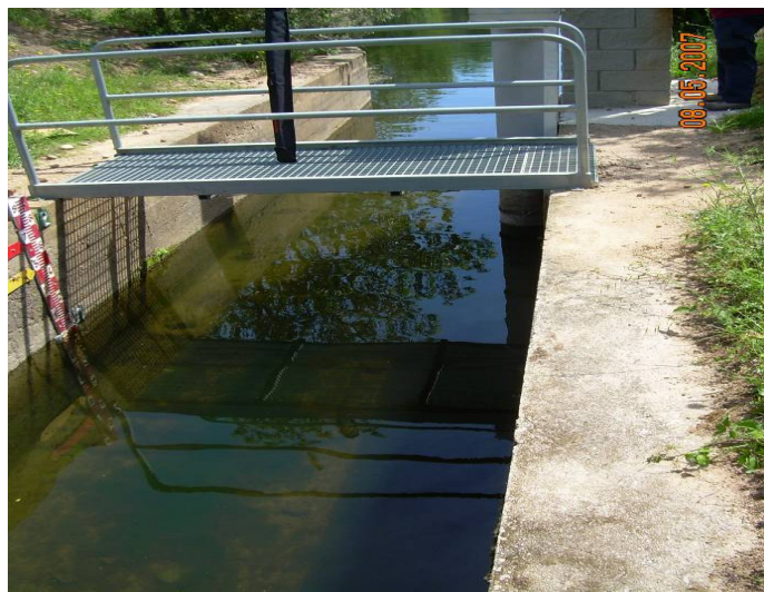
Figure 7. Photo of Canal Marge Esquerra de la Muga
