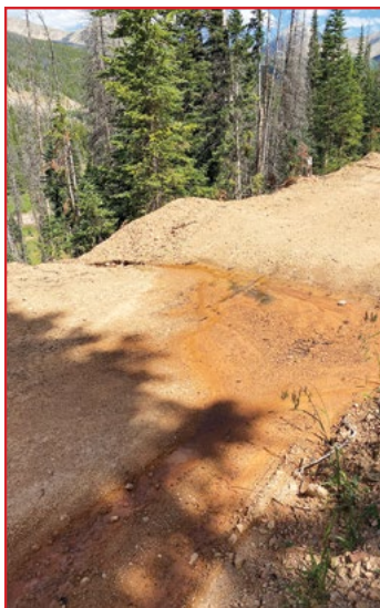
Barra de agua que desvía el drenaje superficial y reduce la velocidad de escorrentía. Foto: CSFS
