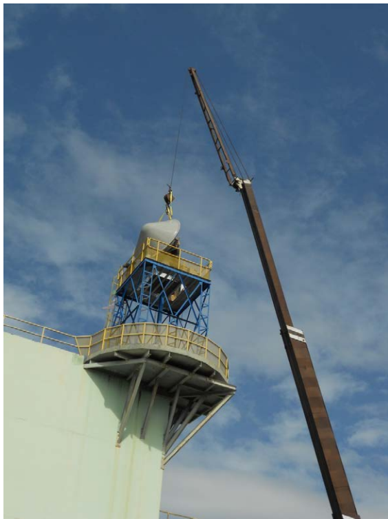
(d) Mounting Antenna onto Pedestal
